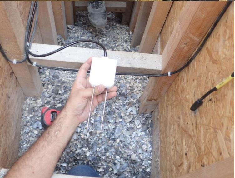
**Muros de estructura ligera de madera rellenos con concha de mejillón aislante.**
